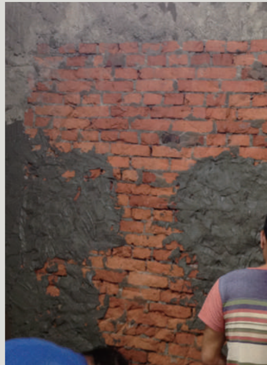
T1 自癒膠土膏 T1 一桶可調配 40 公斤 - 50 公斤 水泥 (磚牆面需批覆完全)
