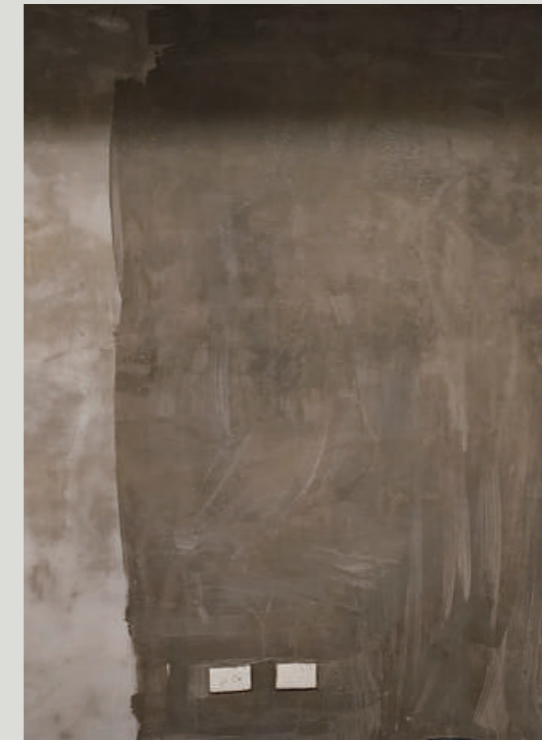
T1 自癒膠土膏 T1 一桶可調配 40 公斤 - 50 公斤 水泥 厚度：3-5 毫米
