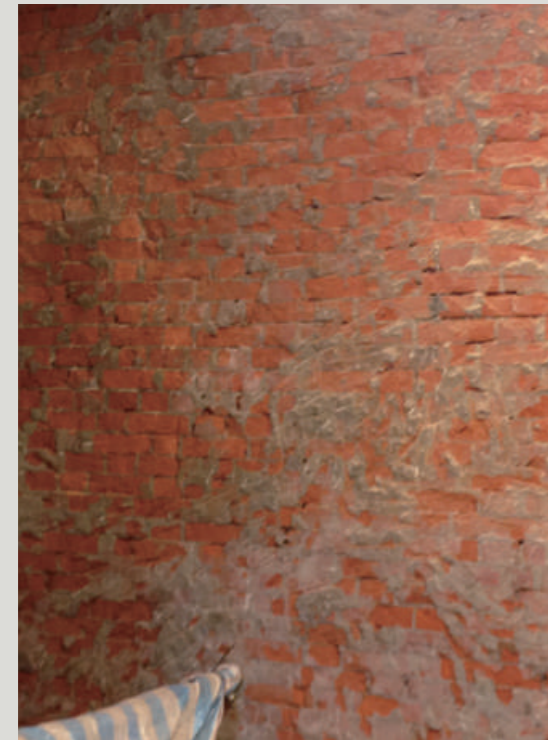
打除至露出原始結構面
