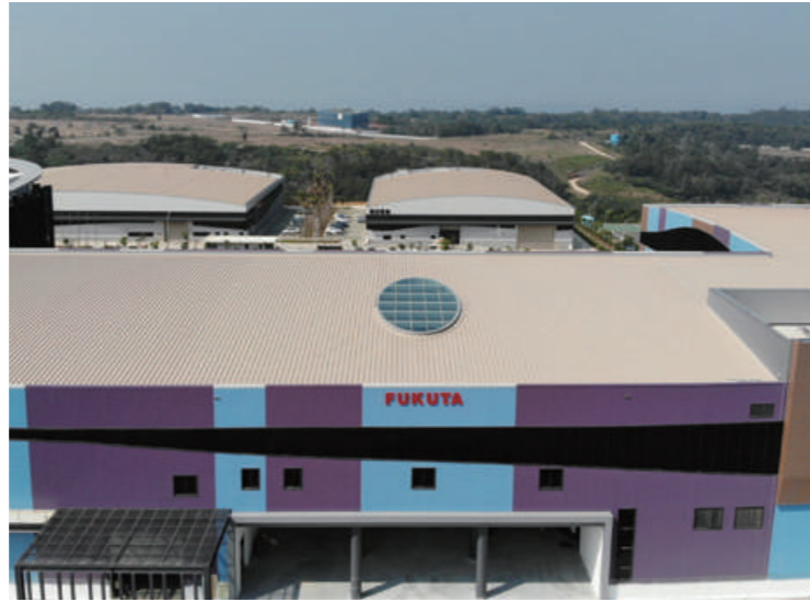
富田電機銅鑼場 | 外牆、廁所 T3 砂漿
