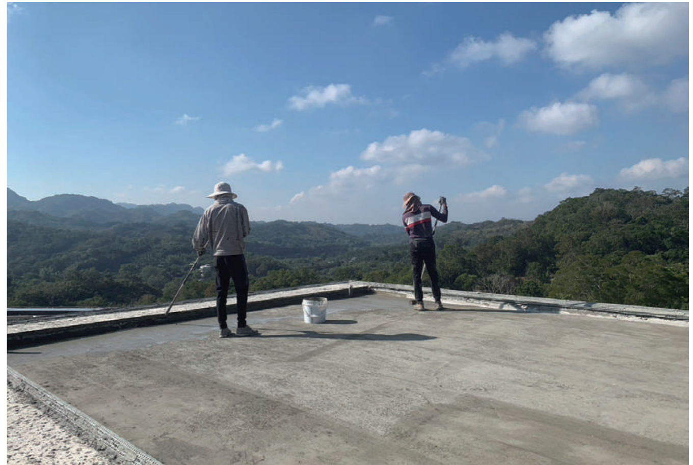
三灣 | 外牆屋頂 T1 土膏
